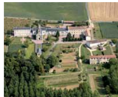
Le couvent de Salvert - Vue aérienne
