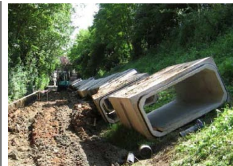
Pose d'une canalisation d'eau pluviale – parc d'artillerie Poitiers 2007
