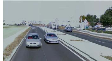
Photo : la RN 10 avec évolution de statut de voie express en boulevard urbain
