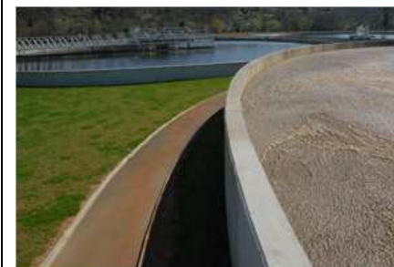
Décanteur et clarificateur d'eaux usées STEP de la Folie – Poitiers
