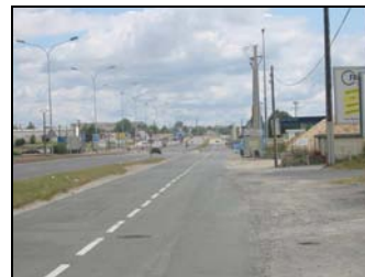
Photo : Avenue de la Loge et contre allée avant aménagement
