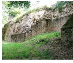
Mur de soutènement d'époque gallo-romaine à l'ouest du bourg (Béruges)
