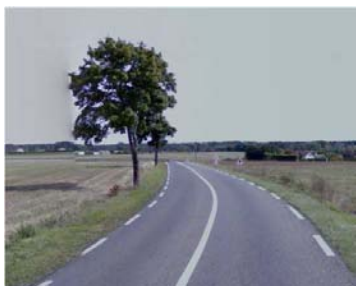
Photo : Tronçon entre le RN149 et Moulinet (Migné-Auxances)
