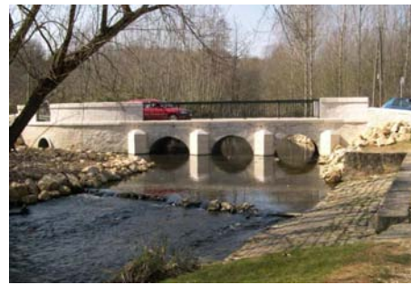
Pont de la Casette – vallée de la boivre (Biard).
