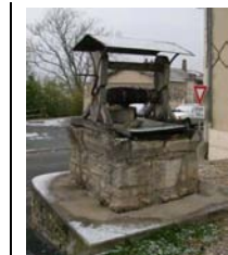
Puit 5 Rue de la Tonelle (Montamisé)
