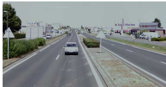
Photo : RD910 au droit de la zone commerciale des Portes du Futur
