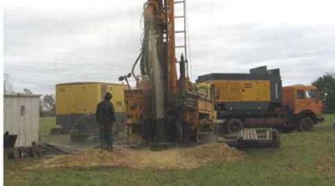
Photographie : essai de forage pour la recherche en eau potable au Sablon - 2008
