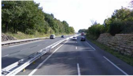
Photo : la RN 10 aux abords de Fontaine et Croutelle avec son statut de voie express
