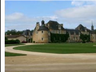
Logis des Piliers (Fontaine-le-Comte)
