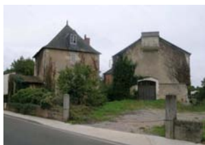
Usine hydroélectrique et Moulin à l'Essart (Buxerolles).
