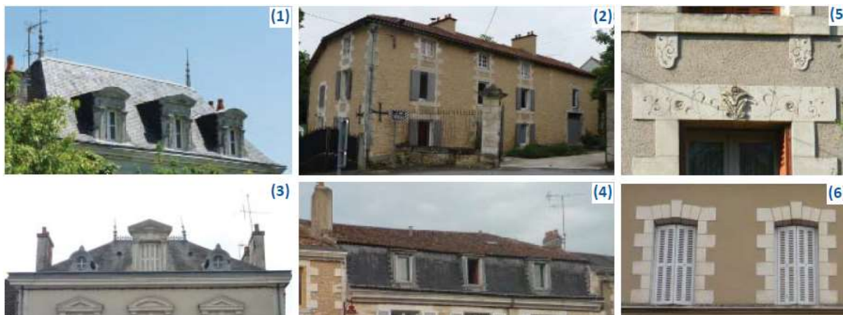
Illustrations 1 à 6 : Illustrations sans valeur réglementaire. L'architecture bourgeoise s'inspire des belles demeures classiques (toitures à forte pente, lucarnes), ou s'inscrit dans la tradition des toitures à pente douce couvertes en tuiles.
