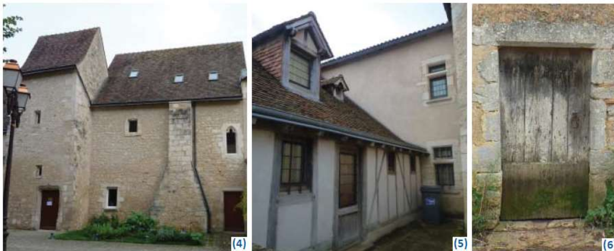
Illustrations 4 à 6: Illustrations sans valeur réglementaire. Quelques constructions ont conservé une toiture à forte pente et une couverture en tuiles plates.
