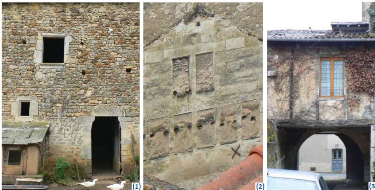
Illustrations 1 à 3 : Illustrations sans valeur réglementaire. La façade principale reçoit généralement un traitement plus élaboré que la façade arrière. Le recours à la pierre de taille en parement est réservé quasi-exclusivement à des programmes religieux. Quelques façades en pan de bois se conservent au-dessus des passages couverts, côté cour.
