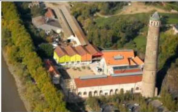
Espace culturel et associatif de la Tour au plomb (théâtre, médiathèque, espace d'exposition, studios de répétition, café concert) dans l'ancienne usine Tréfinmétaux, près de Nantes (44). Sophie Blanchet et Benoît Garnier, architectes urbanistes, Magnum architectes, Zéphyr Paysagistes.
