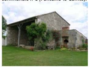
Grange et four – La Gacheterie (Montamisé).
