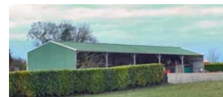
Les teintes du hangar favorisent son insertion paysagère – Les Chilloux Limbre – Migné-Auxances)
