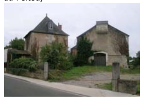
Usine hydroélectrique et Moulin à l'Essart (Buxerolles).
