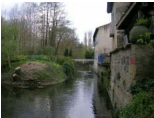
Vue du canal alimentant le moulin de Chaussac (Migné-Auxances).
