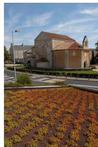
Toiture végétalisée Sédum Espace Mendès France Poitiers
