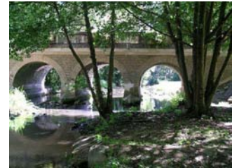
Route du Lavoir – pont sur la Boivre (Vouneuil-sous-Biard).
