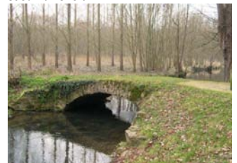
Ponceau sur la Boivre (Biard)
