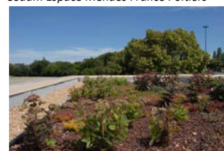
Toiture végétale local technique de la commune au parc de la Roseraie – Poitiers.
